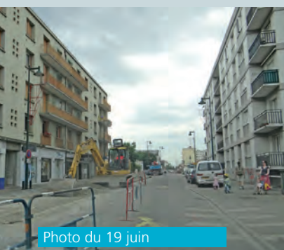
Au tout début des travaux *
