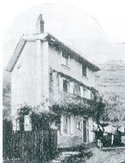
LA POSTE DE SEVERINE (DRE)
