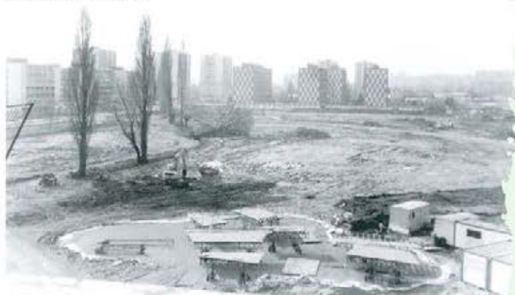
Au démarrage des travaux
