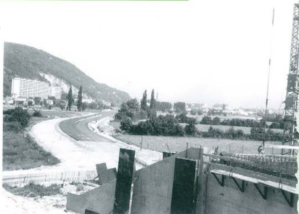
La construction du Pont de Cartale, en 1983-1984
