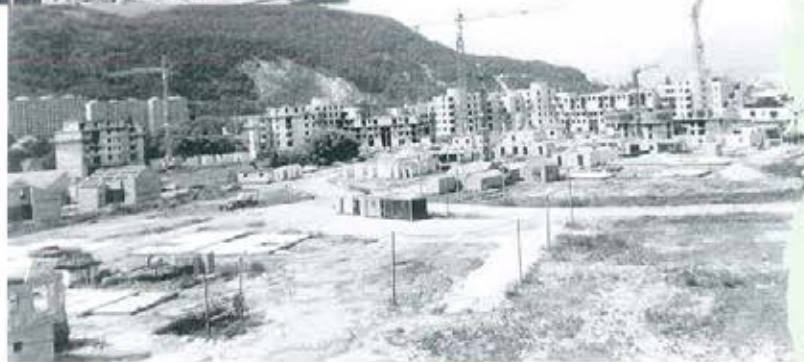
Au démarrage des travaux
