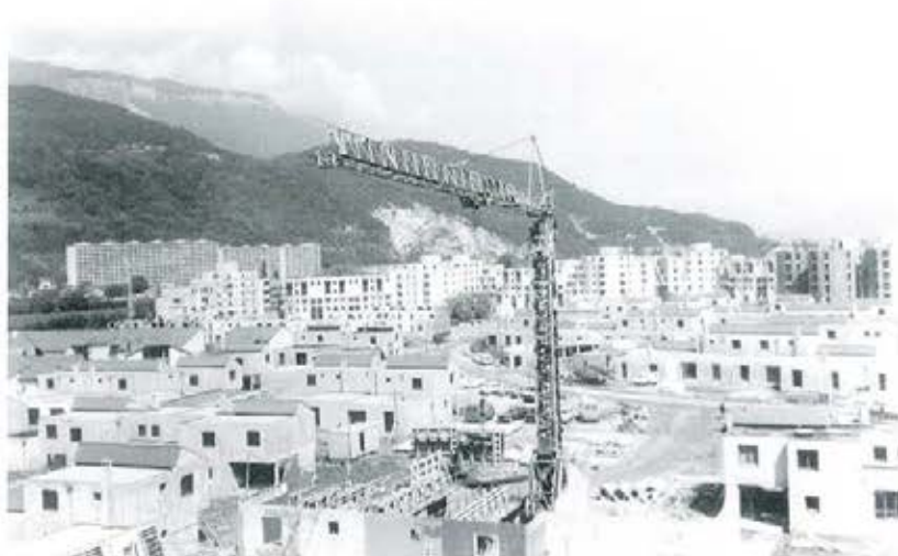
Pendant les travaux
